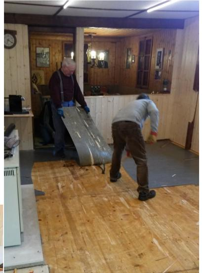
Der Bodenbelag besteht sodann aus Kork-Paneelen von ca. 30 x 90 cm und 10 mm Stärke. Die Paneele sind ein Sandwich aus einem Kork-Oberbelag, der mit einer speziell robusten Polyurethan-Versiegelung beschichtet ist, einer Faser-/
