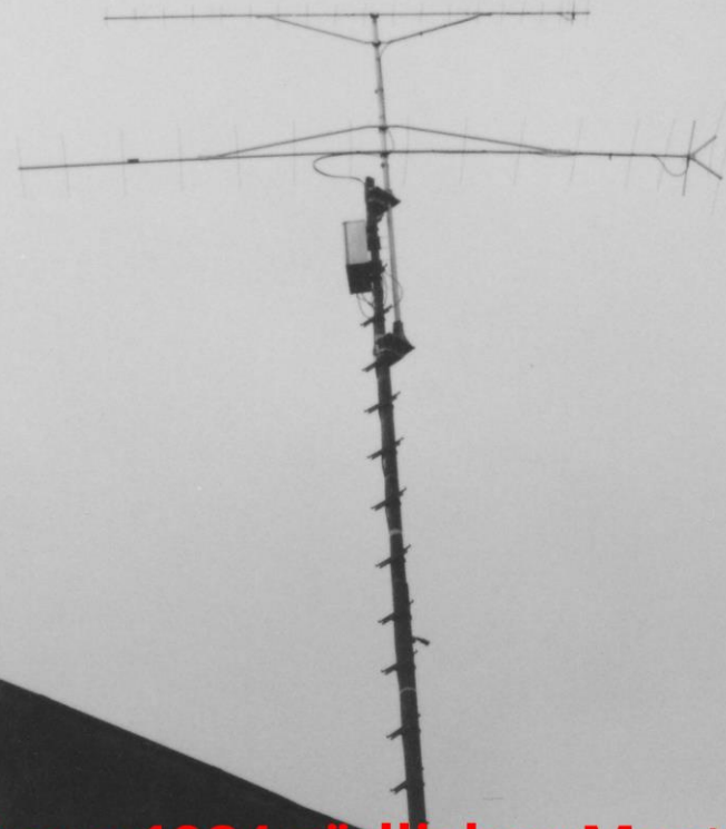
Kurhaus 1984 südlicher Mast 2m und 70cm Antennen
